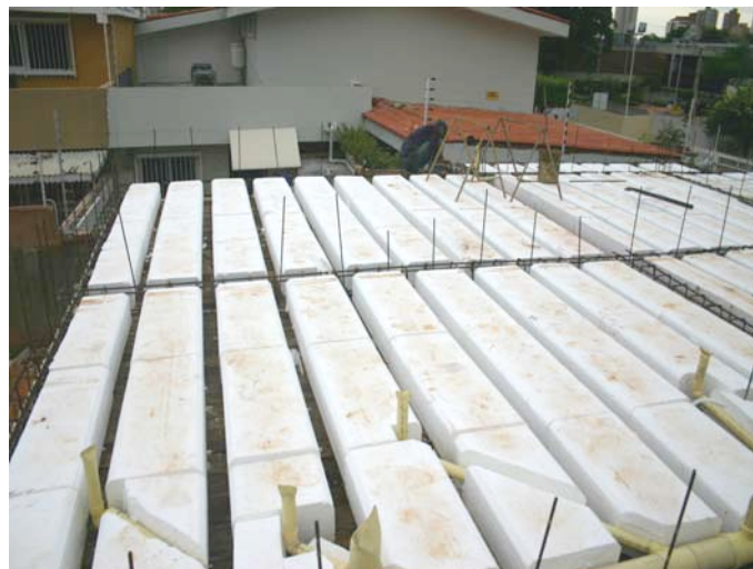
Losa armada en un sentido
