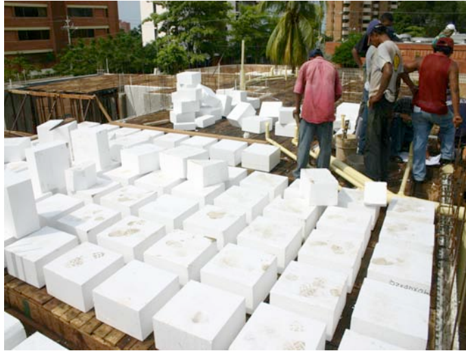
Losa armada en dos sentidos
