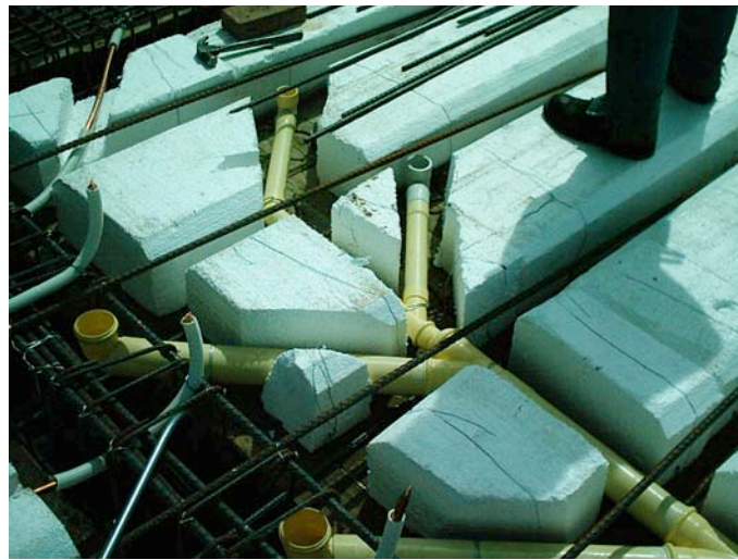
Empotramiento de instalaciones sanitarias
