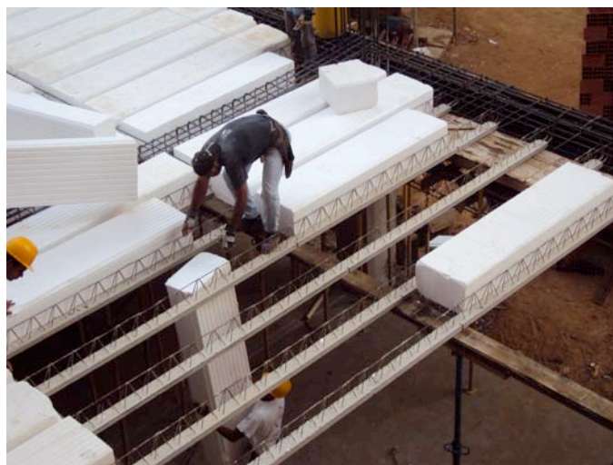
Armado con nervios prefabricados
