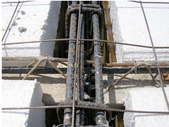
Acero de refuerzo
