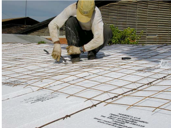
Colocación de malla electrosoldada
