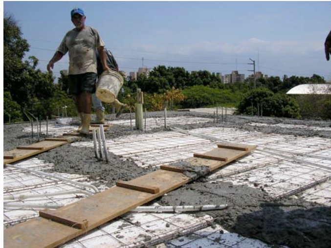
Vaciado con baldes
