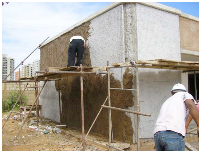
Recubrimiento de las Láminas Aislantes
