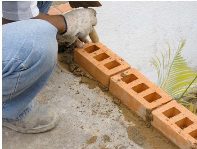
Colocación de bloques de arcilla
