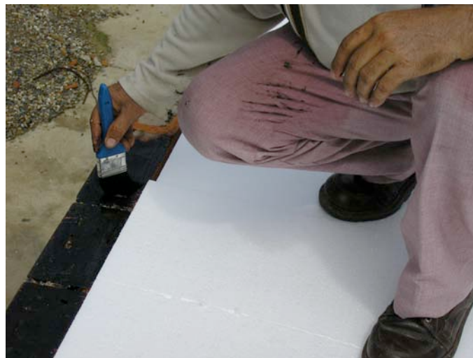
Aplicación de primer adhesivo
