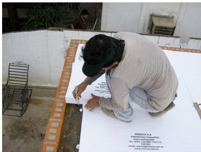
Corte a medida de láminas
