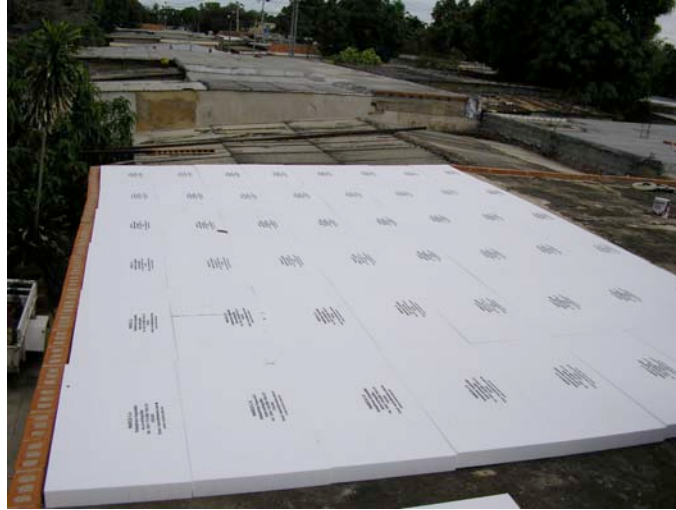
Superficie cubierta con Láminas Aislantes
