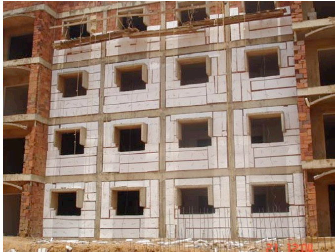
Colocación de Láminas Aislantes
